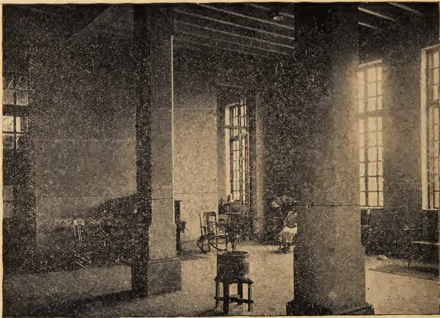
ASILO «VÍCTOR LARCO HERRERA»: PABELLÓN DE MUJERES PENSIONISTAS—SALA DE DÍA
